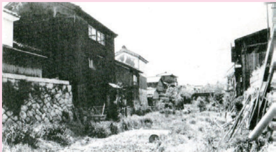
白雲橋を上流より 1974(昭和49)年
