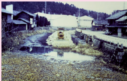
▲浚渫始まる！ 1976（昭和51）年3月
